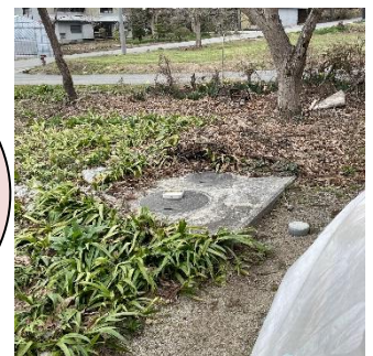
建物北面に浄化槽
