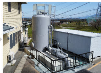
サージタンク更新 整備後
