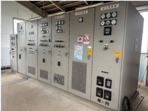
高圧受電盤・機側操作盤等更新
