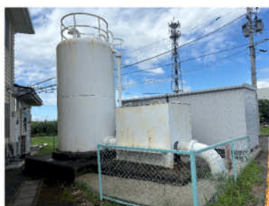
サージタンク更新 整備前
