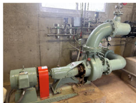
主ポンプ（片吸込渦巻）・電動機等更新
