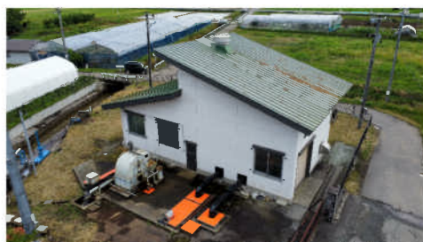
三郷堰第一揚水機場建屋補修 整備前
