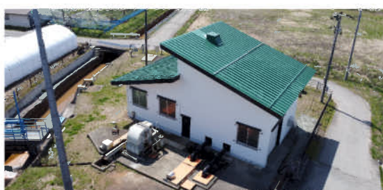
三郷堰第一揚水機場建屋補修 整備後
