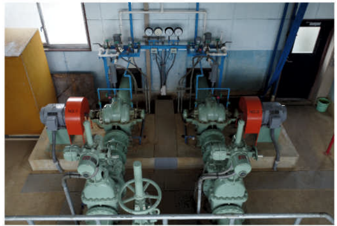
三郷堰ポンプ・電動機等設備整備
