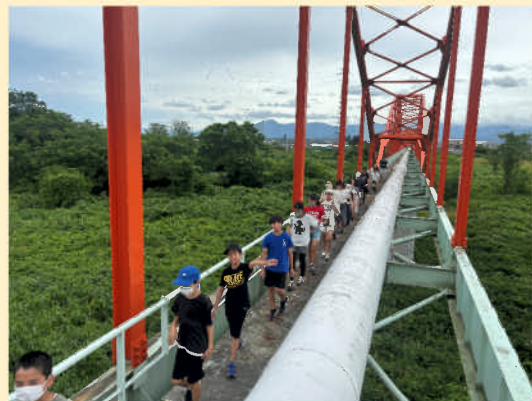
水管橋を渡り施設を学ぶ
