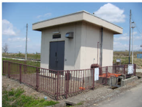
三郷堰第三揚水機場外観
