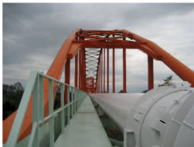
三郷堰水管橋
