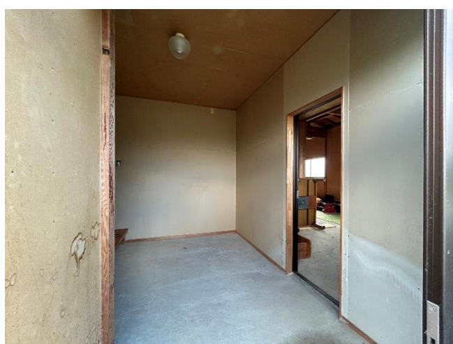
玄関（玄関戸からの中部）
