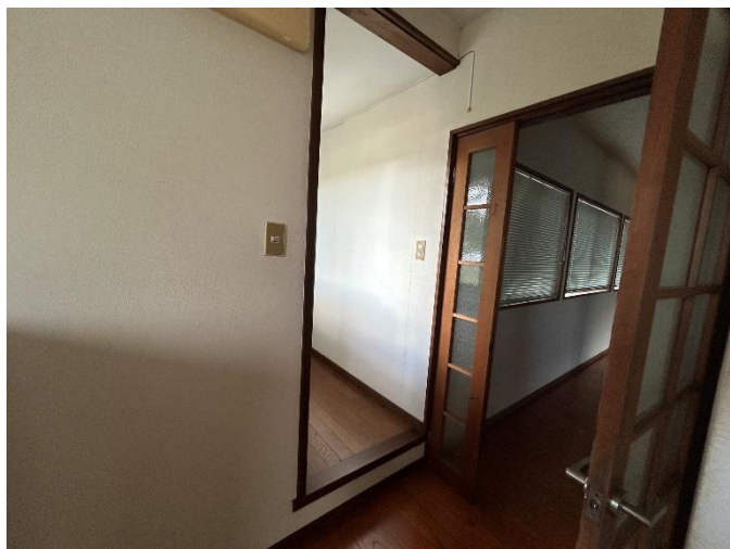
廊下 段差あり
