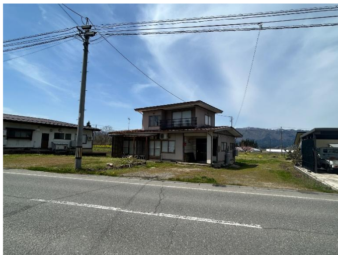
前面道路 東面より
