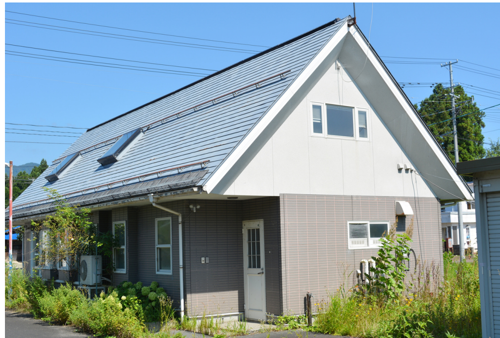
外観（東側から）
