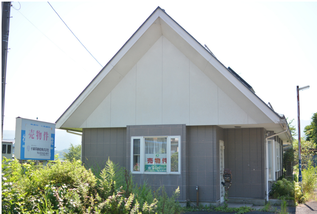
外観（西側前面道路から）
