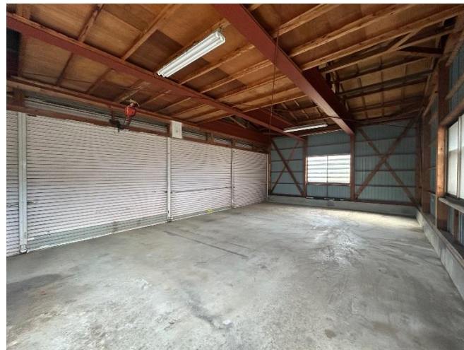
車庫内 ※電動シャッターです
