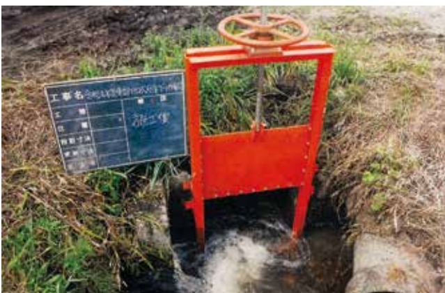
上野地内ゲート更新
