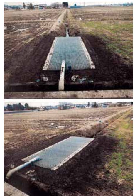
下地内排水路工事
