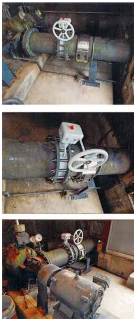
中嶋揚水機場バタフライ弁更新
