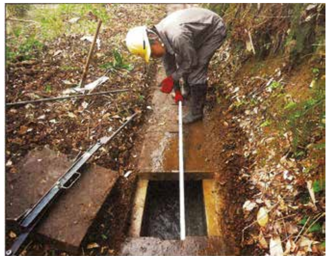
上川原堰水路内の根っこ除去
