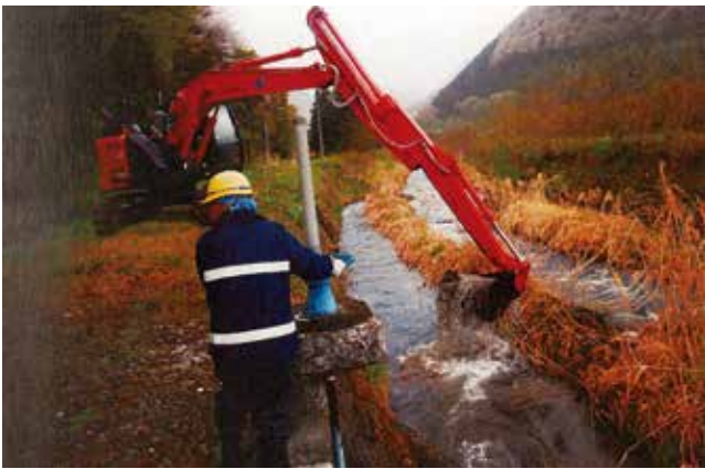
岡田堰取水口土砂浚渫
