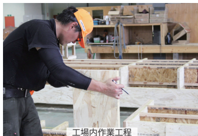
工場内作業工程
