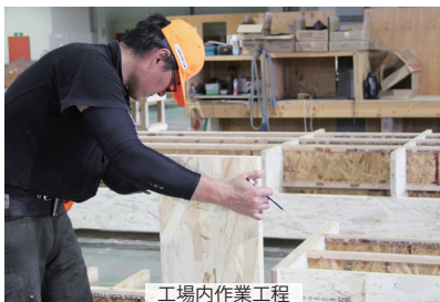
工場内作業工程
