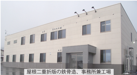
屋根二重折版の鉄骨造、事務所兼工場
