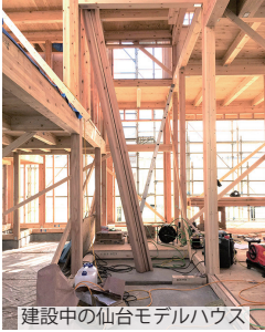
建設中の仙台モデルハウス
