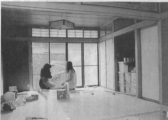
窓にガラス飛散防止シートを貼るスタッフら
