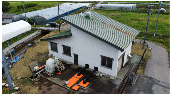
三郷堰第一揚水機場建屋補修
