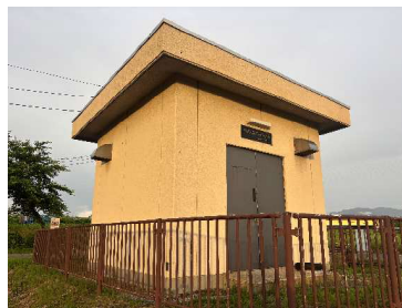
三郷堰第三揚水機場外観
