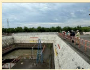
揚水機場の吸水槽を見学
