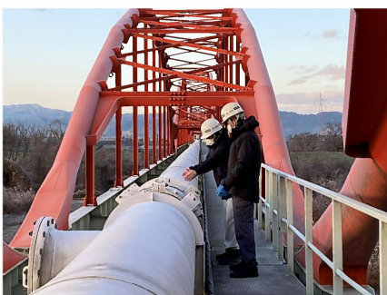
地震発生に伴う施設の緊急点検の様子
