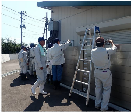
浸水防止対策 止水板設置緊結訓練
