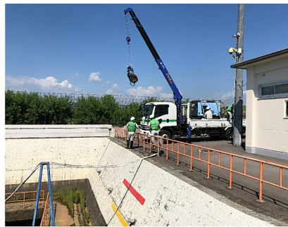
業務委託者の緊急排水訓練状況
