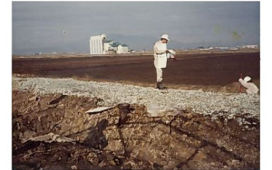
工事の検査状況
