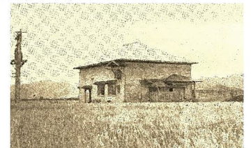
第二段揚水機(高橋)
