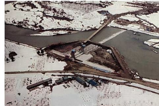
最上川を締切っての頭首工工事
