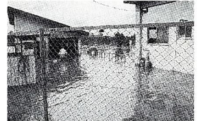
中山揚水機場の水害(H10)
