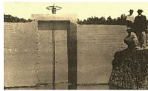
最上川取水口水門 (現事務所西側)
