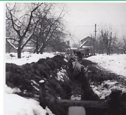
上水路を石積水路にするため出役する組合員
