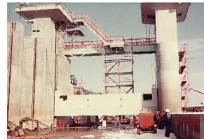
頭首工可動堰の設置状況
