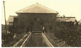
第一段揚水機場 吐出口(現事務所東)
