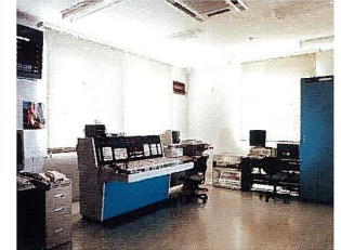
水管理システム完成
