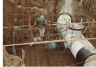
幹線送水管埋設工事(中山町から大蔵町まで)
