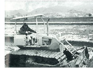
面工事 仕上・整地作業状況
