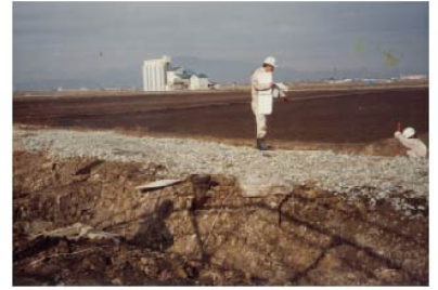
工事の検査状況
