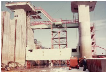
頭首工可動堰の設置状況
