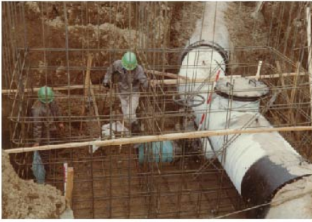
幹線送水管埋設工事(中山町から天童市まで)
