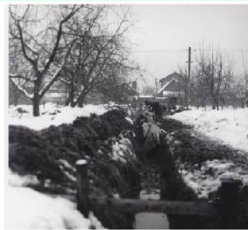
土水路を石積水路にするため出役する組合員
