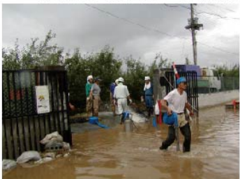
緊急場内排水作業
