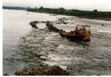
最上川河床低下により ブルドーザにて取水口堰上げ
