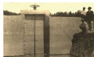
最上川取水口水門 (現事務所西方)
