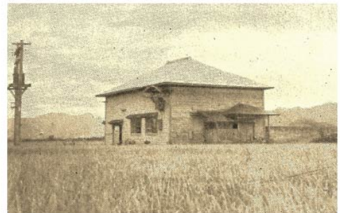
第二段揚水機(高揃)
