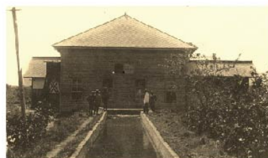
第一段揚水機場 吐出口(現事務所東)
