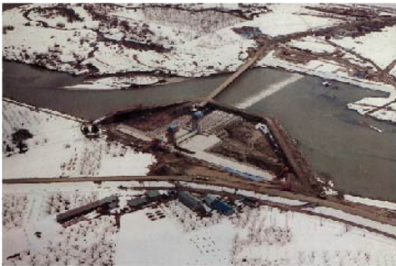
最上川を締切っての頭首工工事
