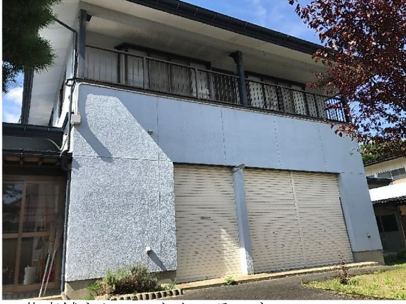
昔店舗をしていたところです。
