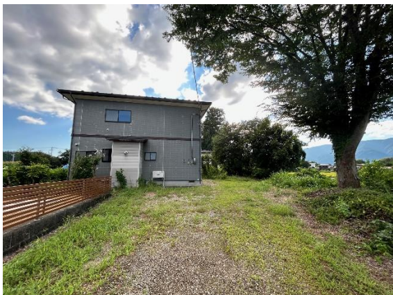
前面道路から見る敷地と建物
