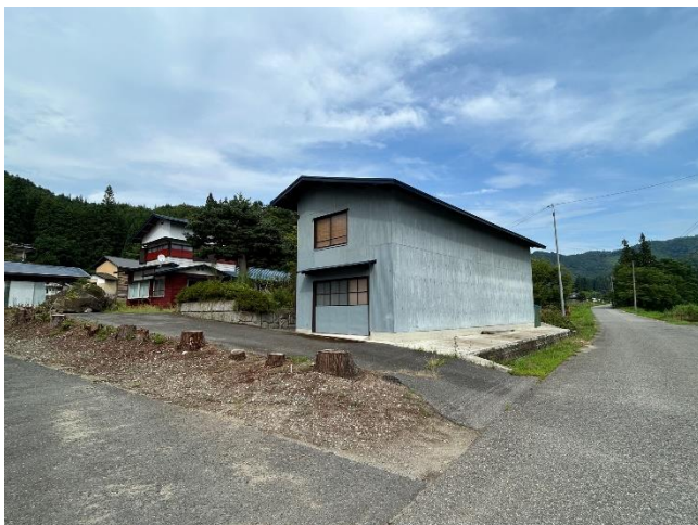
南西より入口状況
