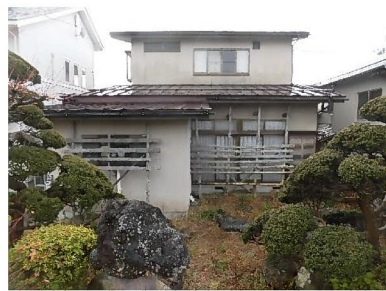
建物北側より
