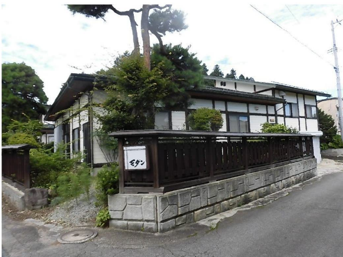
建物南東から
