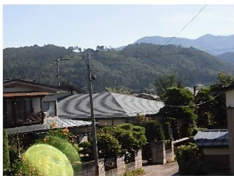
上 平屋部分のモス グリーンの屋根
