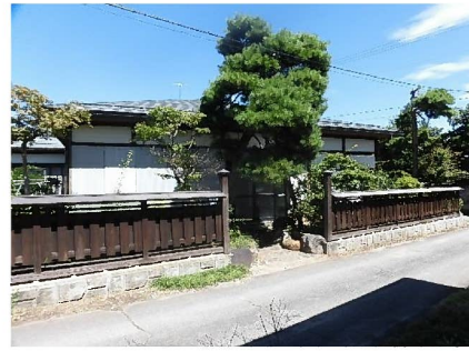
上 南側玄関アプローチ
