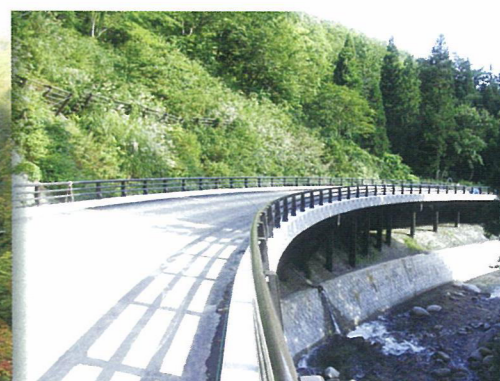
一の木線の陸橋
