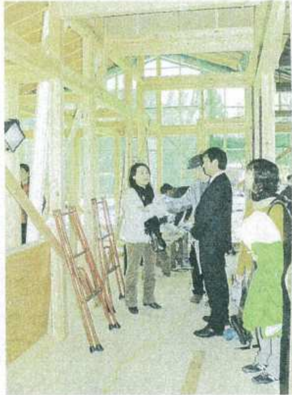
県産材で施工中の住宅を見学する参加者
