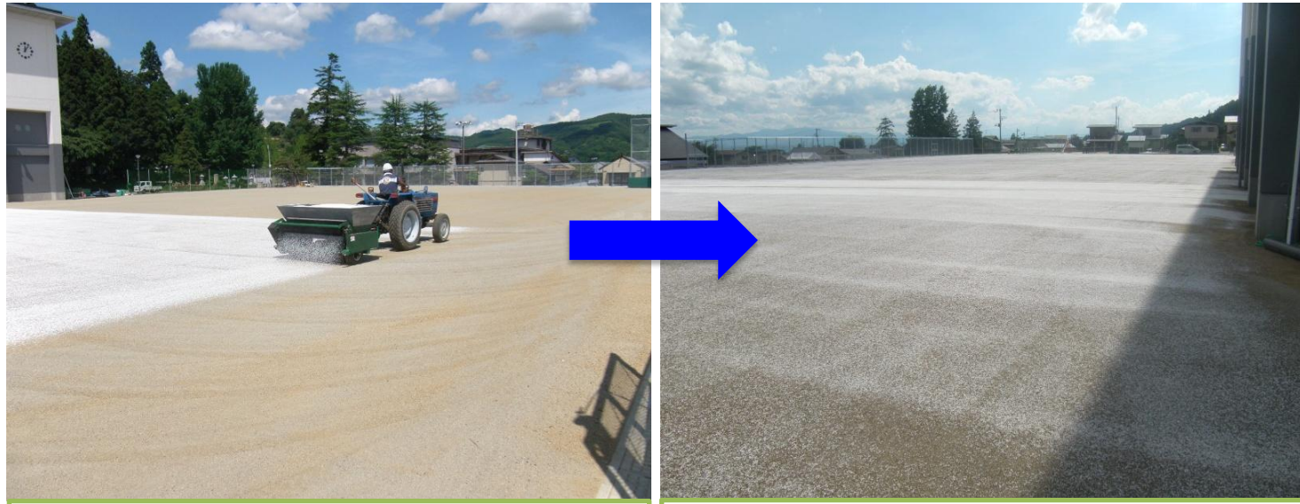
最終の表面仕上げを行っています！
