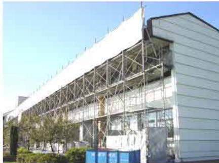
南校舎屋根力パルーフ工事 まもなく完成!
