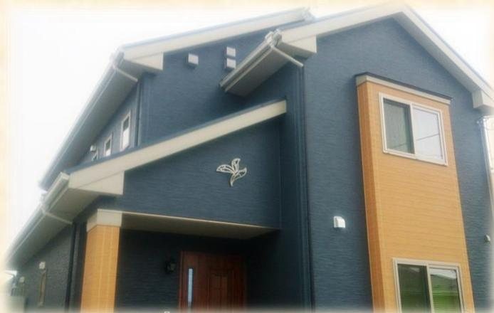
**ここがポイント**「二重通気」とは、構造躯体の両側に設けた二重の通気層により湿気や熱気を排出させ、室内の温度や湿度の上昇を抑える技術となります
