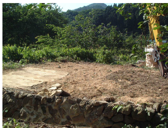
解体後の状況
