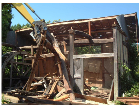
水車小屋東側解体中
