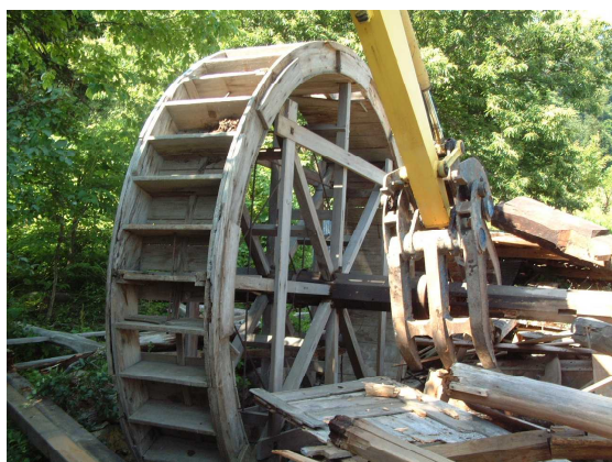
水車小屋解体中
