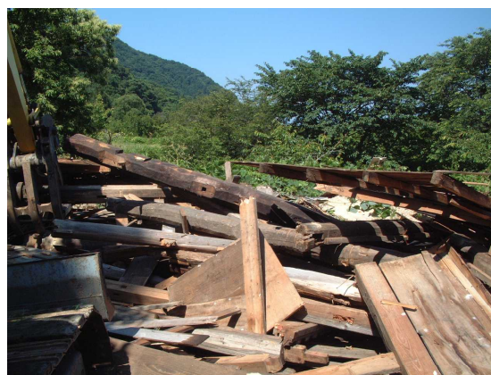
小屋梁その他の材料(釘が一本もなし)
