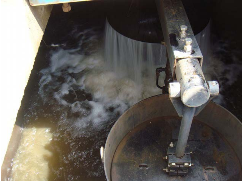
③減勢工での作業風景 (減圧水槽への充水状況確認)
