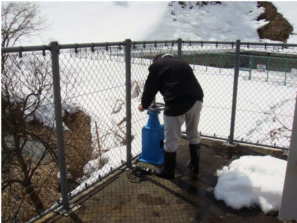
③同上 (減圧水槽が満水になり、減勢工から下流に水を流している状況)
