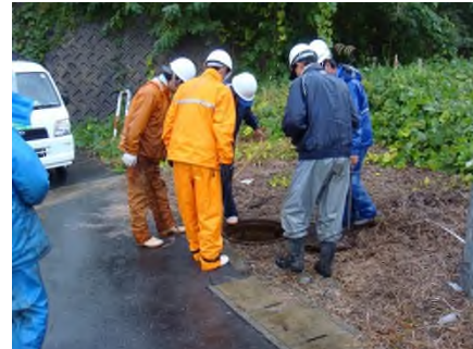
万代大橋東水抜栓での排水状況
