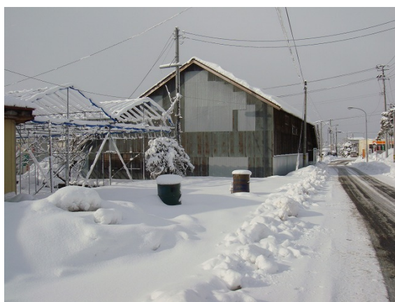
解体後の事務所跡地
