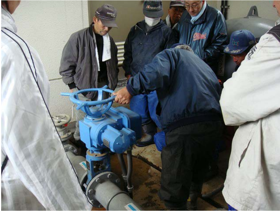
①流量制御弁を操作して配水管に水を流している。
