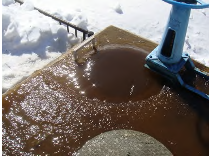
①取水工での作業風景 (受水槽への流入状況)
