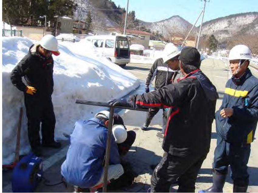
②遅沢水管橋での作業風景 (水管橋手前の制水弁室内の排水作業)
