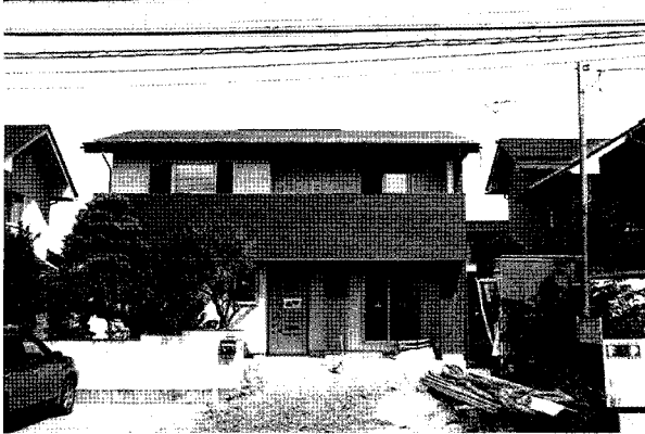
青田 新澤様 住宅新築工事
