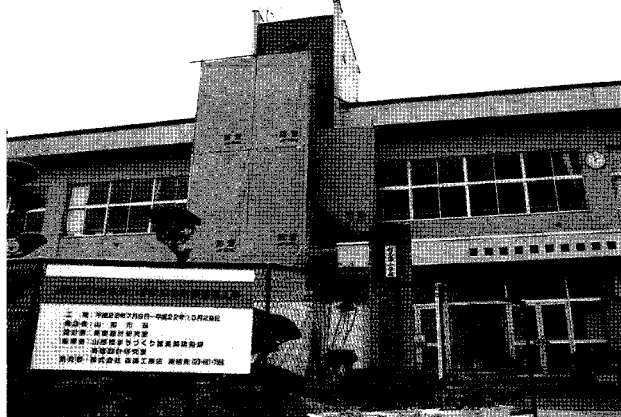
村林沢川学校 校舎耐震補強工事
