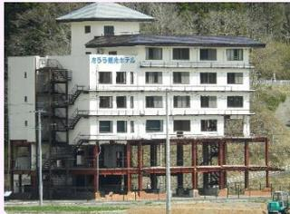
東日本大震災により6階建ての建物の4階まで浸水し、1・2階は完全に破壊されてしまった「たろう観光ホテル」
