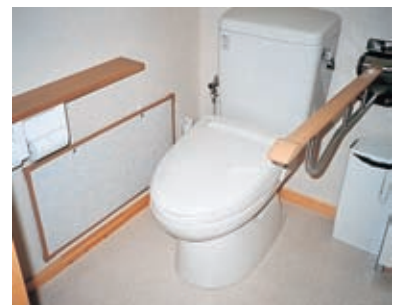
壁面に取り付けた壁掛け暖房パネル
