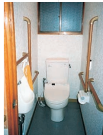
洋式便器に交換し、手すりを設置した改修後のトイレ
