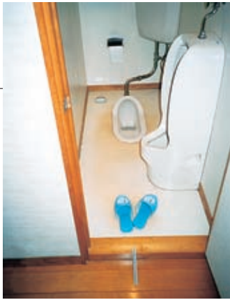
改修前は和式便器と男性用小便器が
