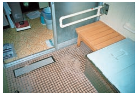
段差を解消し腰かけ椅子と手すりを設置した浴室
