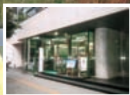
▲第一オフィスビル (ステンレス建具工事)
