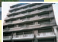
▲山一地所一番町マンション (ベランダ・フェンス工事)
