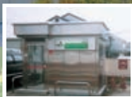
▲JA仙台ATMブース (ステンレスブース施工)
