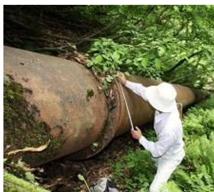
外周約 2.6mの送水管
