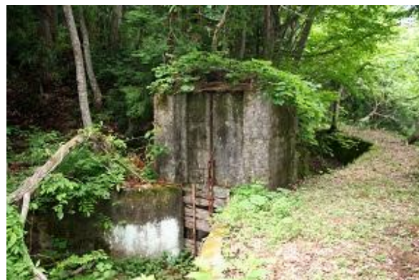
送水管に向かう水門。現在は コンクリートで塞がれています
