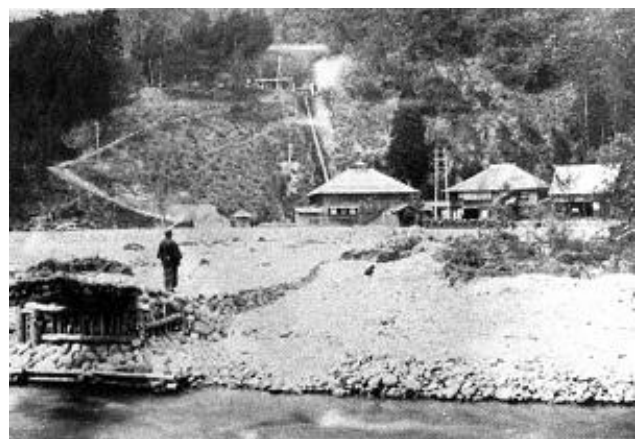
旧小野川水力発電所（写真提供：米沢市）
